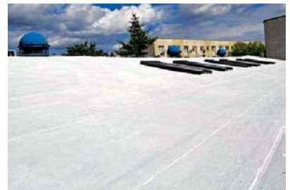
Fot.5 i Fot. 6.Malowanie dachu hali produkcyjnej farbą odbijającą promienie słoneczne, oraz już pomalowany dach taką farbą. Źródło: fotografie ze zbiorów autora.
