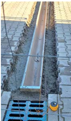
Fot.3 i Fot.4. Instalacja dodatkowego odwodnienia liniowego oraz zbiornika szybkiej retencji wód opadowych. Źródło: fotografie ze zbiorów autora.
