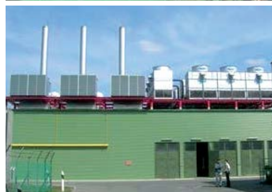
Fot. 17 i Fot.18. Zakład CHP widok wnętrza – silnik gazowy GE Jenbacher J620 E01 oraz widok ogólny, zewnętrzny zakładu CHP zbudowanego w oparciu o 3 wspomniane wyżej jednostki kogeneracyjne. Źródło: fotografie ze zbiorów autora.
