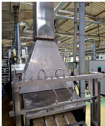
Fot. 11 i Fot. 12. Instalacje wyciągowe nadmiaru ciepła i oparów produkcyjnych z urządzeń pakujących i procesowych. Źródło: fotografie ze zbiorów autora.
