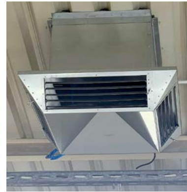
Fot. 13 i Fot. 14. Jednostka chłodzenia wyparnego, widok z zewnątrz z dachu hali produkcyjnej, oraz wewnątrz hali produkcyjnej. Źródło: fotografie ze zbiorów autora.
